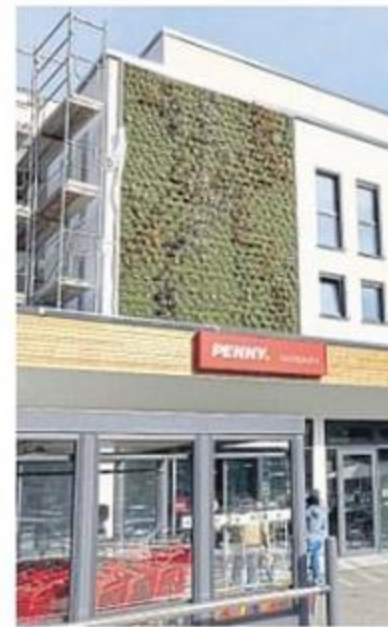
In der Ferne überragt das grüne Fassadenelement am Hochhaus das städtische Gewirr aus Farben und Formen (links). Wer im Super-8-Hotel eincheckt oder an der Zentralplatzecke unterwegs ist, kann das 5,8 mal 21 Meter große Element aus der Nähe betrachten (kleines Bild unten, links). Laut Pflanzplan gibt es 105 Reihen mit jeweils 29 Gewächsen. Auch in der Beatusstraße sind an Penny und Hoefler grüne Fassaden zu sehen. Fotos: Katrin Steinert
