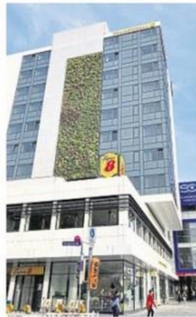
In der Ferne überragt das grüne Fassadenelement am Hochhaus das städtische Gewirr aus Farben und Formen (links). Wer im Super-8-Hotel eincheckt oder an der Zentralplatzecke unterwegs ist, kann das 5,8 mal 21 Meter große Element aus der Nähe betrachten (kleines Bild unten, links). Laut Pflanzplan gibt es 105 Reihen mit jeweils 29 Gewächsen. Auch in der Beatusstraße sind an Penny und Hoefler grüne Fassaden zu sehen. Fotos: Katrin Steinert
